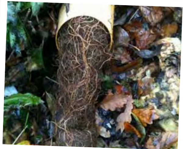
Verkrautetes Drainagerohr
