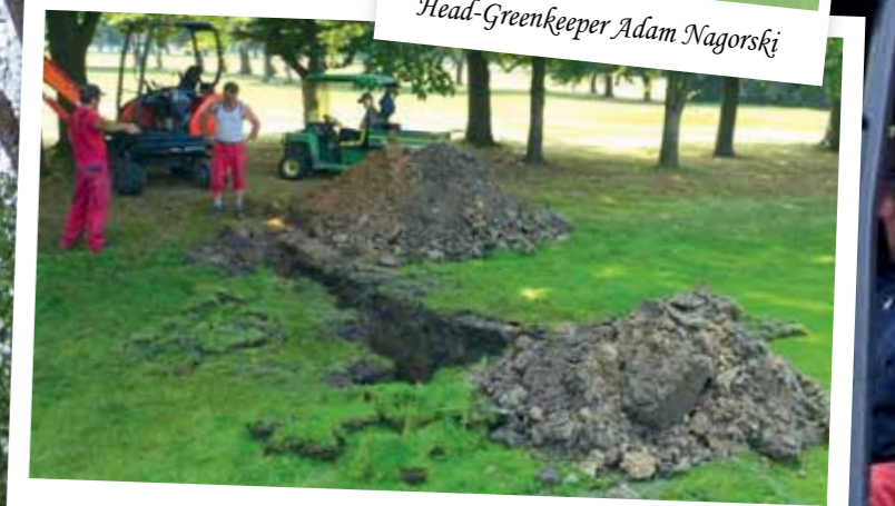
Reparatur der Drainage hinter dem 16. Grün
