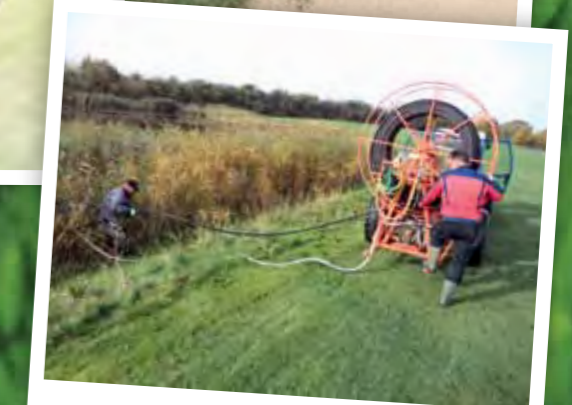
Spülung der Drainage
