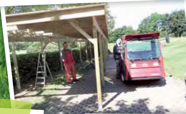
Bau des Trolley- und E-Cart Unterstandes
