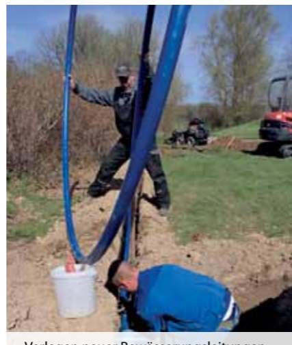
Verlegen neuer Bewässerungsleitungen vor dem 20. Grün
