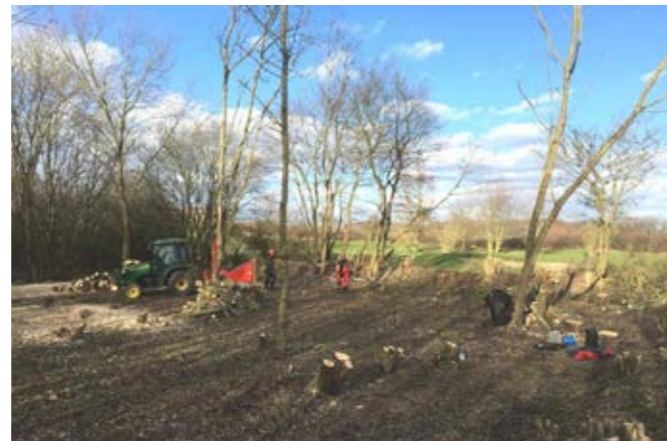
Aushulzung an der Bahn 4
